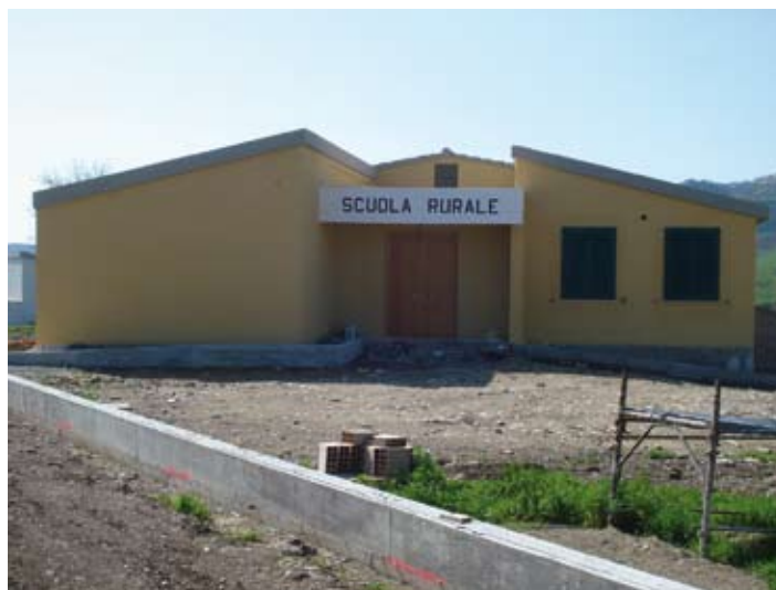
Il Centro visita durante i lavori di ristrutturazione
